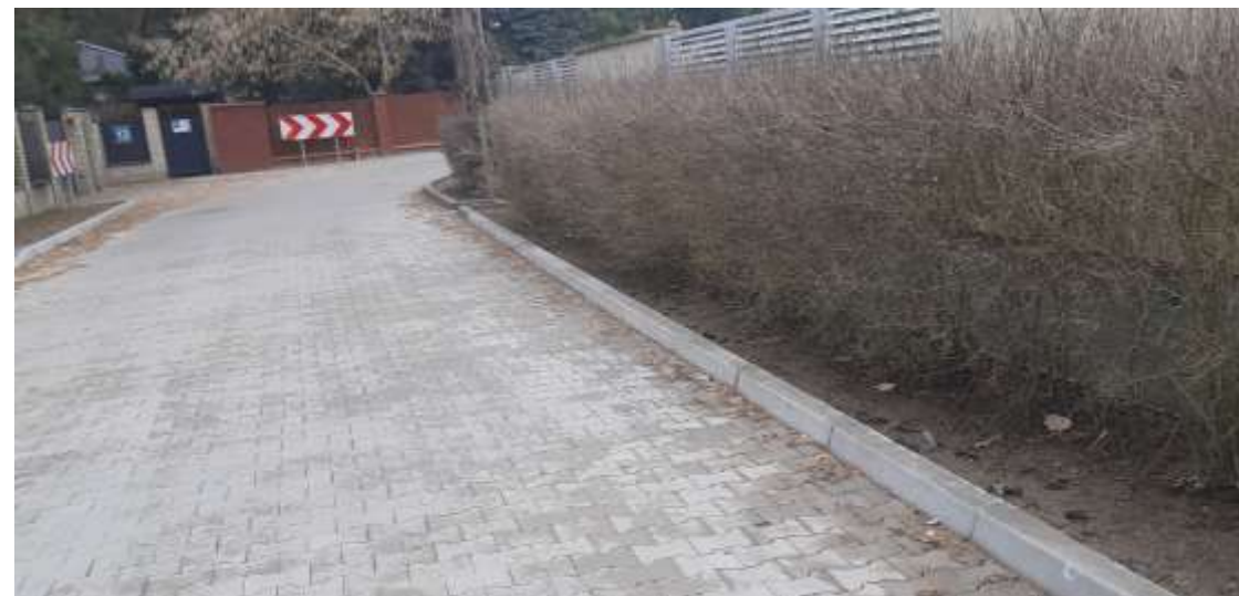
ul. Sosnowa, Hornówek, gm. Izabelin
